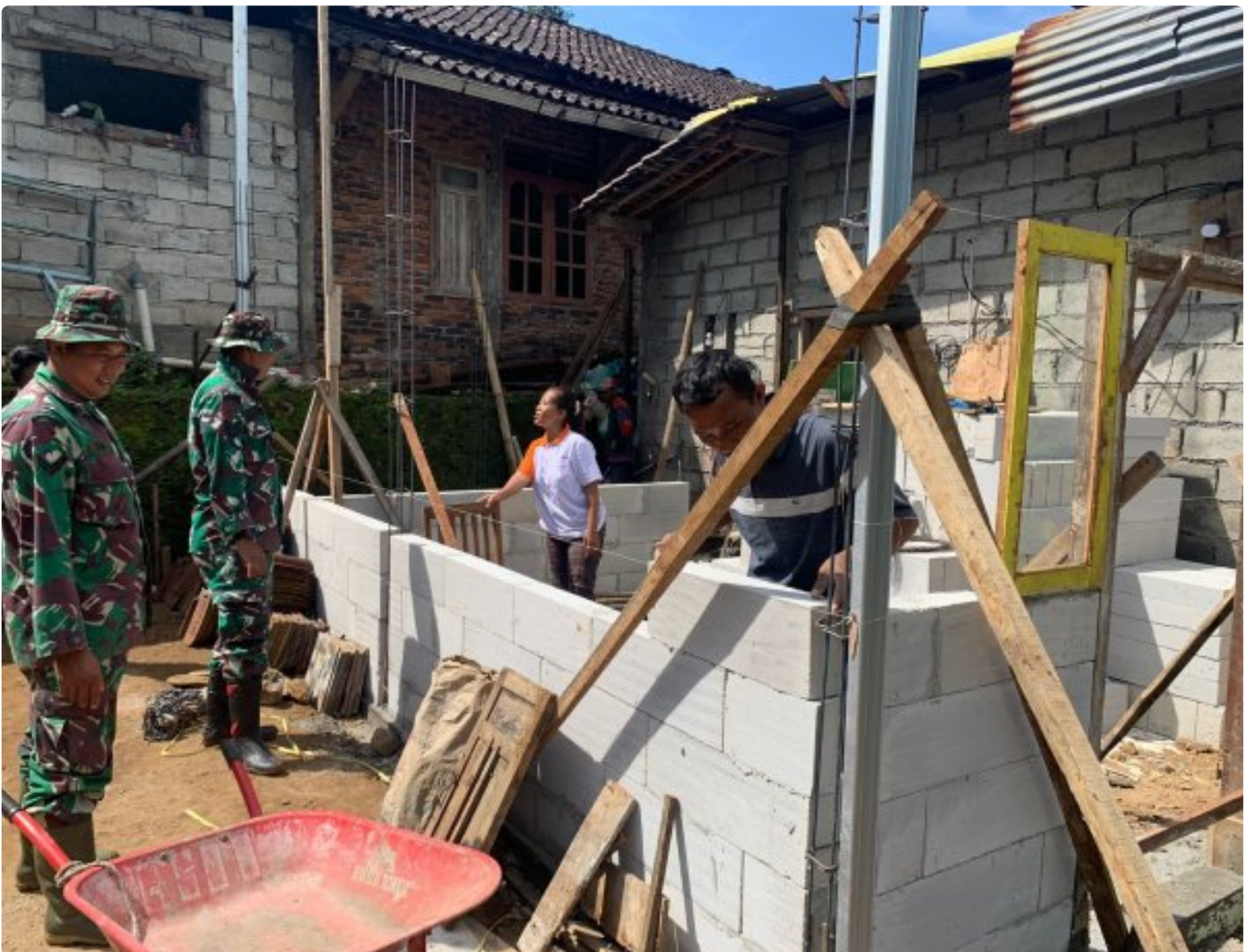
Pemasangan Dinding Menggunakan Herbel
